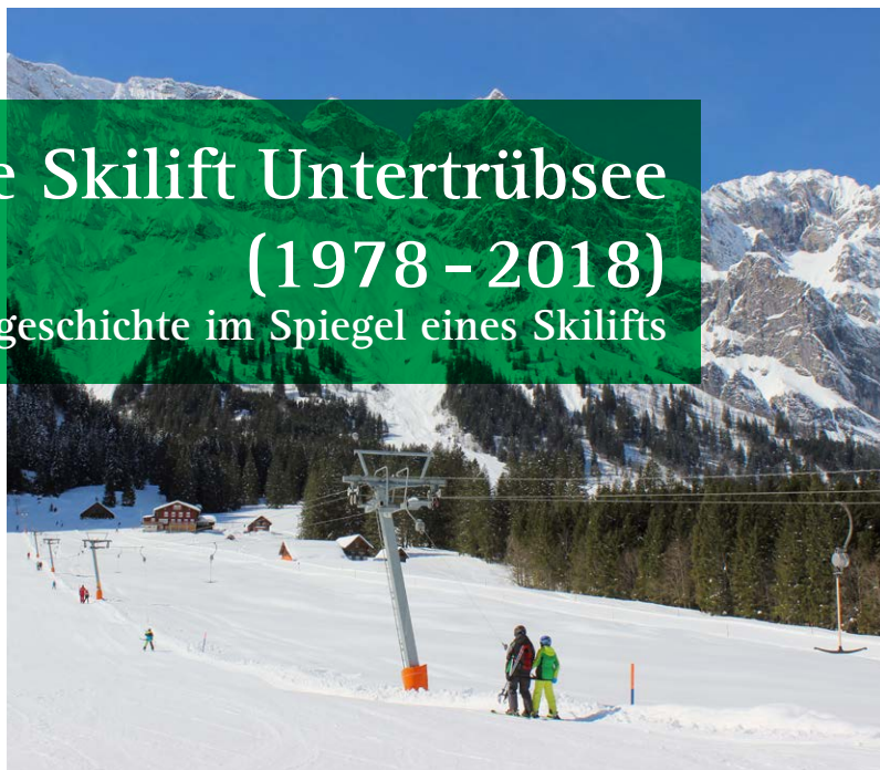
Ein Blick auf das Trasse des Skilifts Untertrübsee von der Talstation aus.
